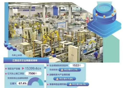
图为南昌海立电器有限公司智慧生产车间。
